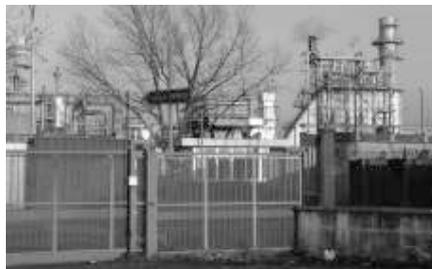
ecoincentivi del Cip6 per il grande impianto da 100 megawatt, che fornisce all'Enel l'energia elettrica prodotta dalla combustione del metano e che riscalda, tra l'altro, il grande stabilimento automobilistico
